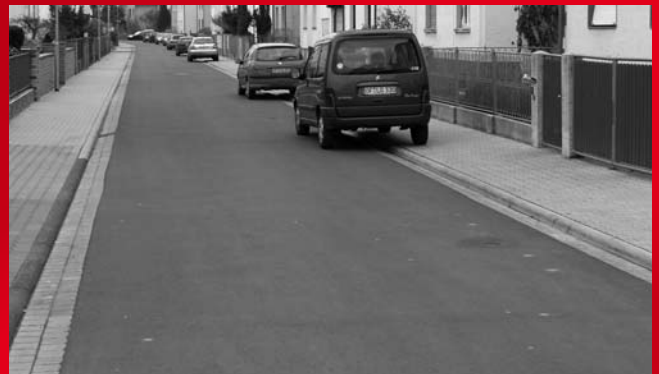
Friedrich-Ebert-Straße Mainflingen: Beispiel für abgeschlossene Sanierung.
