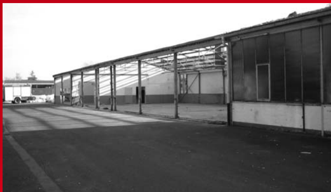
Bedarfsgerechte Unterbringung der Feuerwehren: Umbau in Mainflingen
