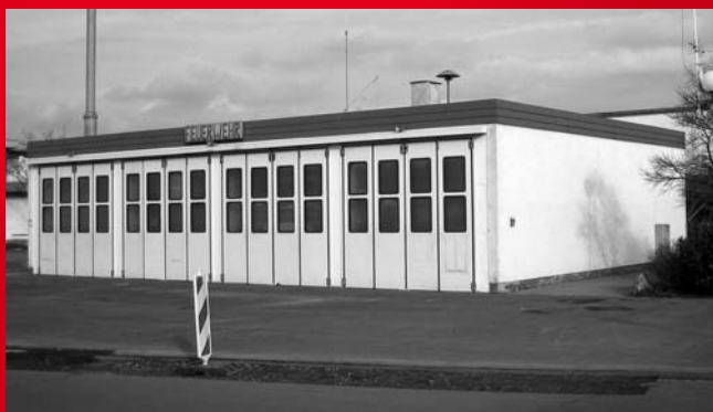
Aufzeigen von alternativen Finanzierungsmöglichkeiten für das Feuerwehrhaus Zellhausen
