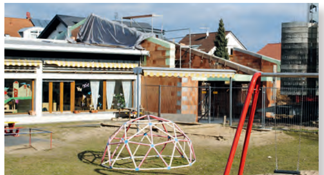
Umwelt- und Sozialpolitik: Energetische Sanierung KiTa Zellhausen
