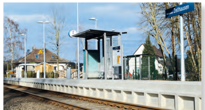
Moderne barrierefreie Infrastruktur am Bahnhof Zellhausen
