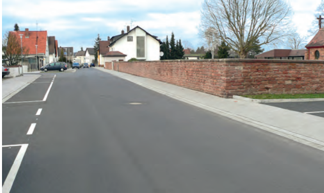
Straßen- und Kanalsanierung mit restaurierter Friedhofsmauer
