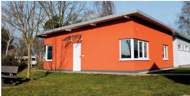
Bereichert die Naherholung am Mainflinger See: Neues Funktionsgebäude
